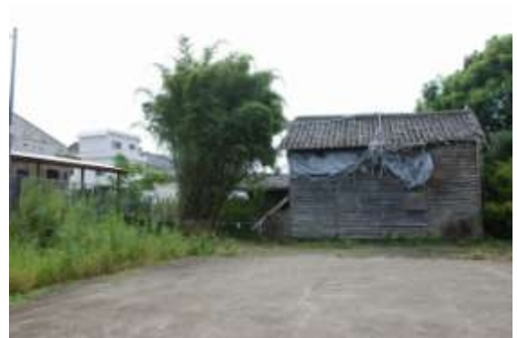
空き家となった建造物
