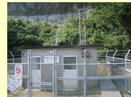
②大島浄水場
