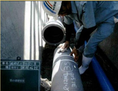
送水管布設工事
