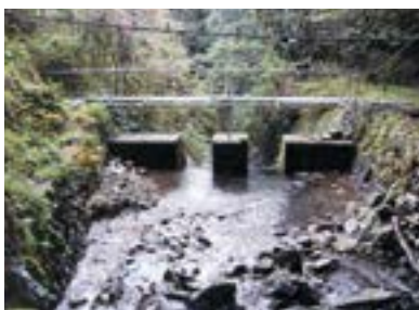
㉕ 堰堤上流より
