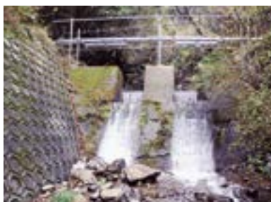
㉖ 堰堤下流より
