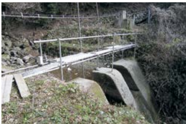
写真 1-3-3 溝口谷川取水口
