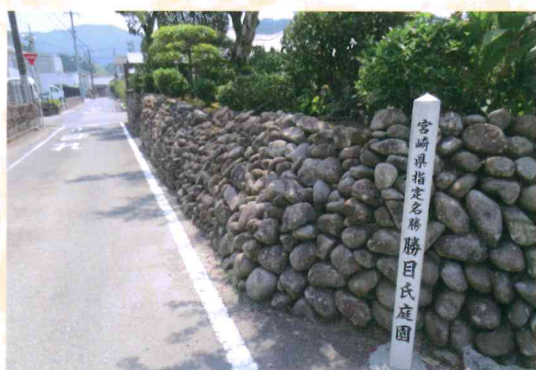
石垣の修理前
