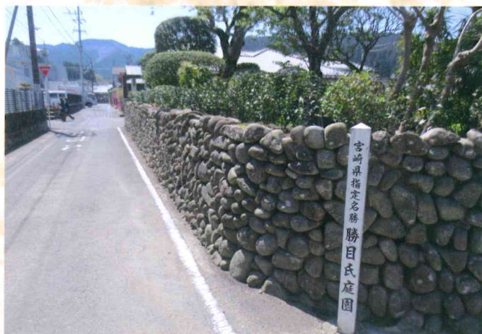
石垣の修理後
