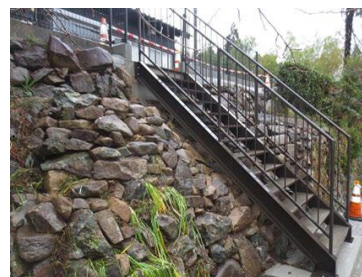
復旧後の様子
