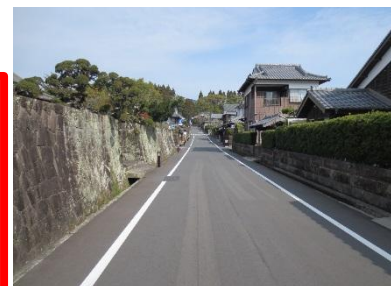
電線地中化後の通りの様子
