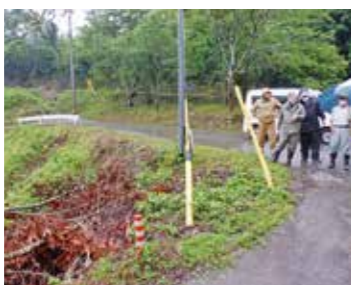
危険箇所調査
