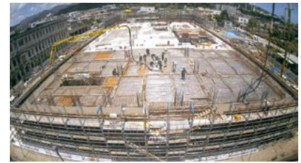
1階コンクリート打設(2階床) (令和4年6月28日撮影) ※6月末時点 建築主体工事 (1工区)進捗率 62.25%
