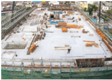
屋上打設完了(令和4年9月27日撮影) ※9月末時点 建築主体工事(1工区) 進捗率 76.47%
