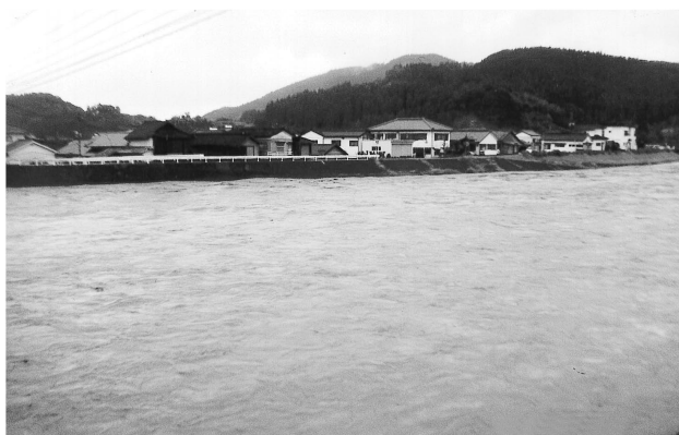
本町橋上流台風時河川状況
