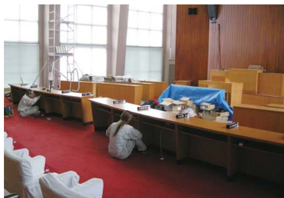
工事中の議場
