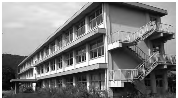
解体予定の旧北郷中学校校舎
