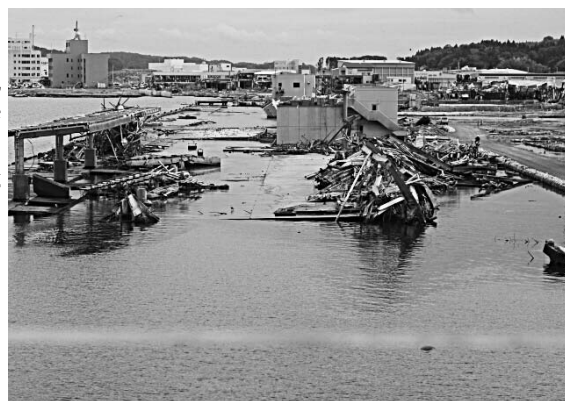
被害を受けた気仙沼漁港
