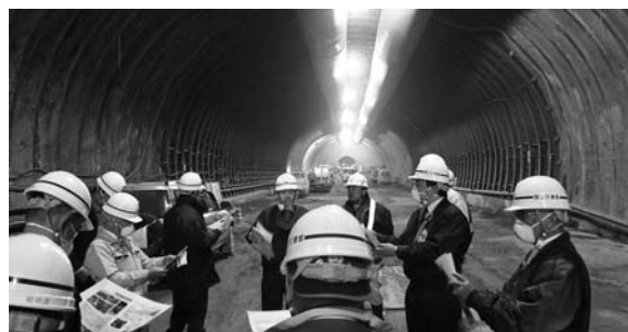
芳ノ元トンネルの現況について説明を受けました
