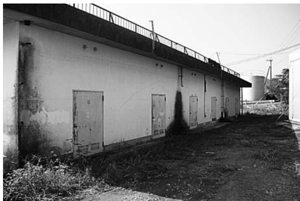
改修予定の漁具倉庫
