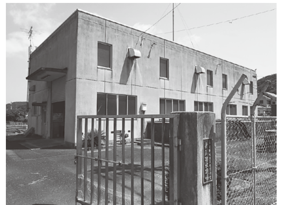
改築更新箇所の新開排水機場
