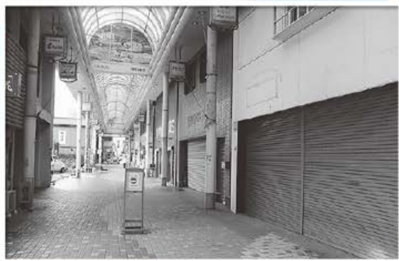
中心市街地活性化基本計画の事業対象となるアーケード通り
