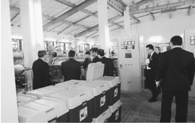
現地視察(高度浄水設備)
