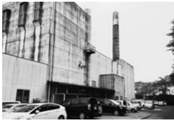
来年度、解体される旧清掃工場
