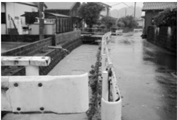
大雨時の市道山川線の河川状況
