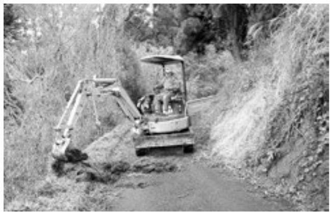
農道補修作業のようす
