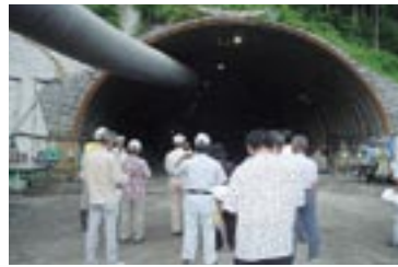
東九州道「猪八重トンネル」
