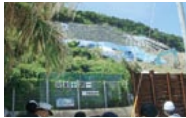
国道220号災害復旧現場
