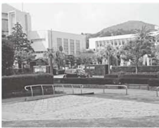
築60年を経過し、取り壊し予定の本庁舎と議会棟
