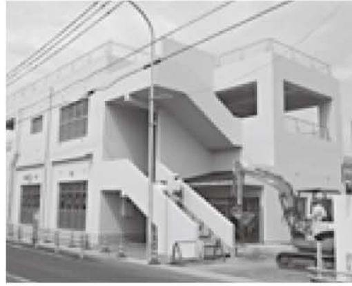
大堂津津波避難ビル
