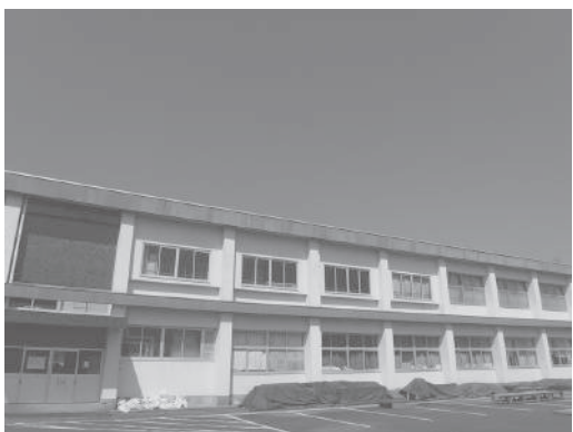
計画的に備蓄が進む日南市備蓄倉庫
