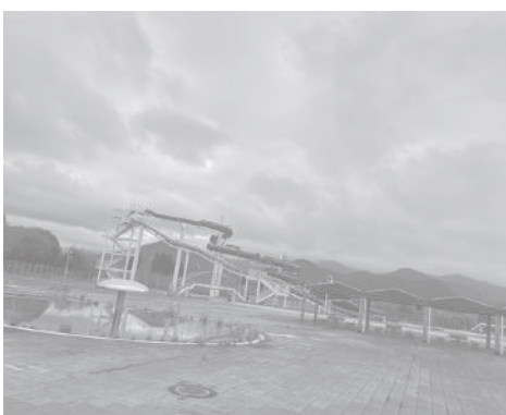
老朽化した市民プール
