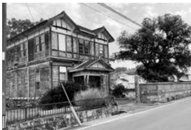
老朽化している旧飯田医院
