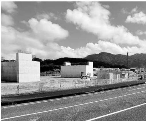
工事が進む(仮称)油津インターチェンジ付近の状況
