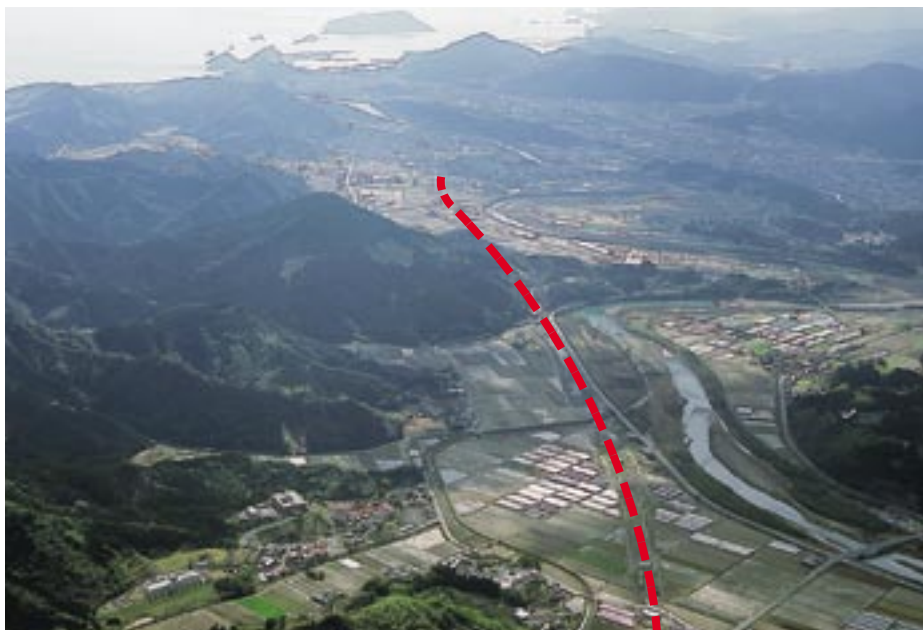
建設中の東九州自動車道日南～北郷区間（上空からの風景）
