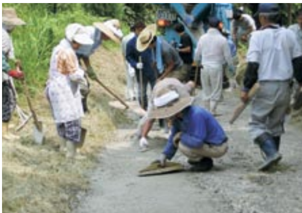
地域住民による道路の補修作業
