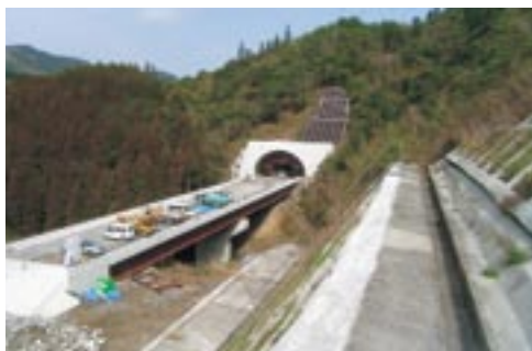
年見第一トンネル入口
