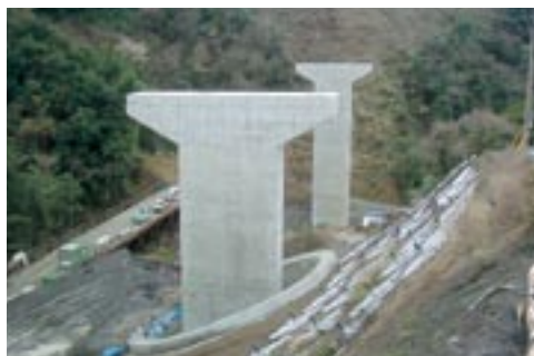
北河内二号橋
