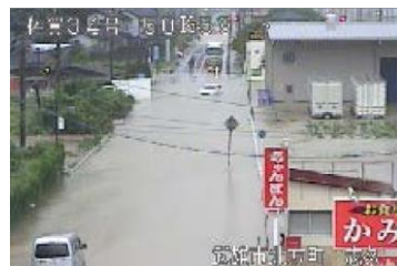
令和3(2021)年8月大雨被害 (佐賀県武雄市六角川の浸水状況) 出典：国土交通省「水害レポート 2023」
