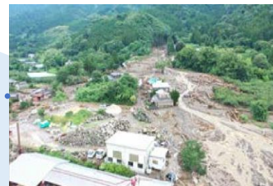
令和5(2023)年6月大雨被害 (福岡県久留米市土砂災害の状況) 出典：国土交通省「水害レポート 2023」
