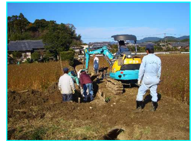
コンクリート二次製品水路の布設状況
