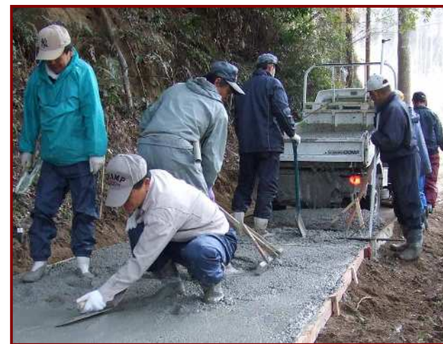
コンクリート打設状況(コンクリート舗装)
