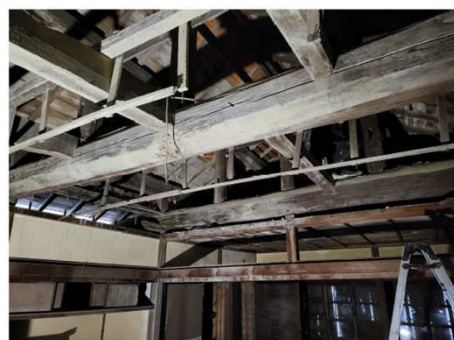
(主屋2階) ※天井が崩落し吊り材だけが残る
