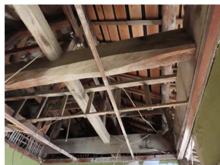
(小屋2階) ※天井部分が劣化して崩落
