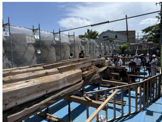
R7. 6月 解体工事現場説明会
