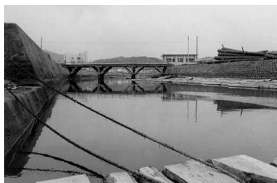
▲S39頃の堀川運河支流 (奥は曙橋)
