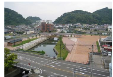
▲堀川夢ひろば・夢見橋
