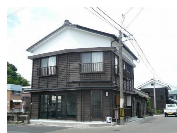
▲景観形成推進事業補助金を活用して改修された民家
