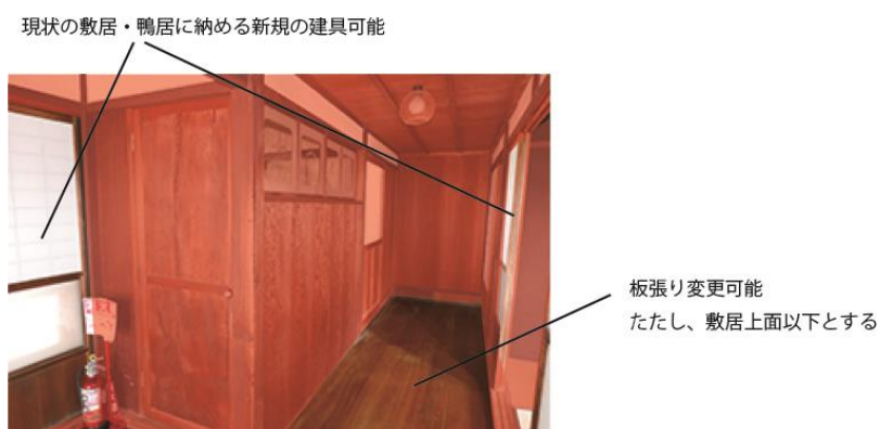
図3-12 旧山本猪平家 本屋 増築部繋廊下部分
