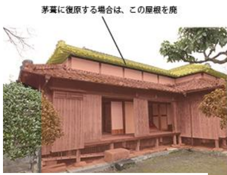
図2-7 旧伊東伝左衛門家 主屋屋根
