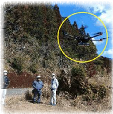
レーザー計測作業
