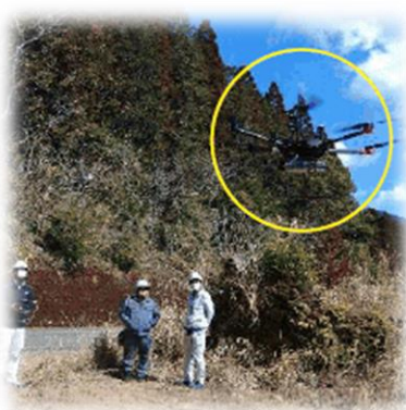
レーザー計測作業
