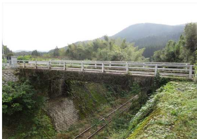
図 10 鉄道を跨ぐ橋梁の例（日南市管理 中講跨線橋）
